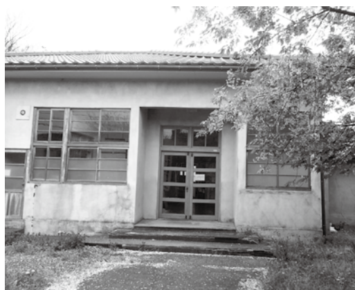
平屋建ての事務所棟
