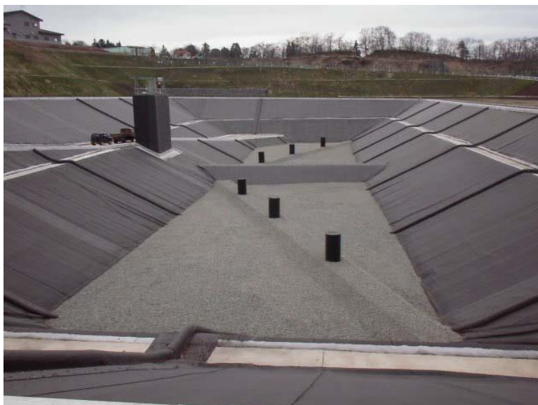
図 5 - 2 - 13 オープン型処分場の集水設備構造
