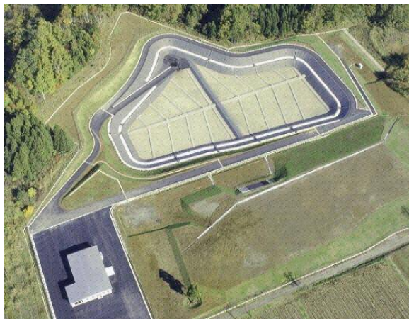
図5-2-1 オープン型処分場の外観
