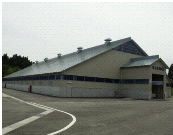
図5-2-2 クローズド型処分場（屋根固定型）の外観
