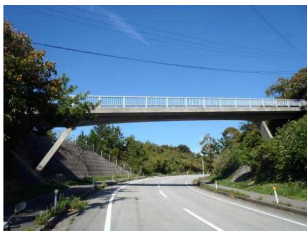
写真全景 (コンクリート橋) (岩野橋)
