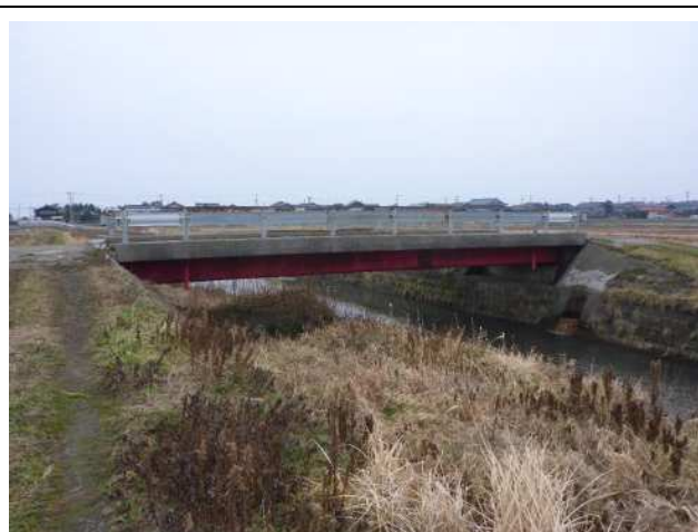
写真全景 (鋼橋) (下久知3号橋)
