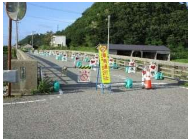
通行止めの処置による迂回路対応（高千の入川橋）
