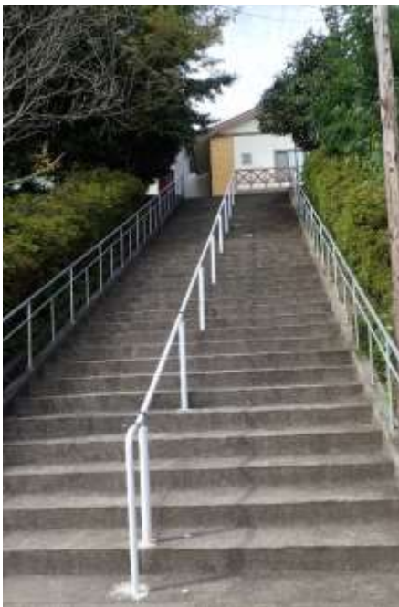
高低差のある階段へのガードパイプ設置（赤泊小）
