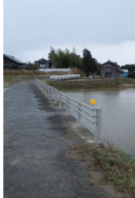
ガードパイプ設置（背合地内）
