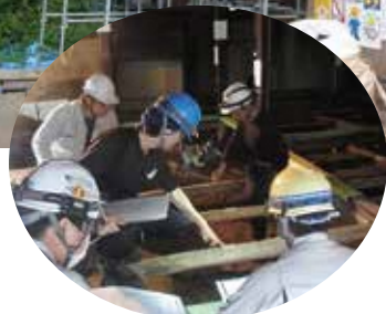
調査と部材の取り外し
