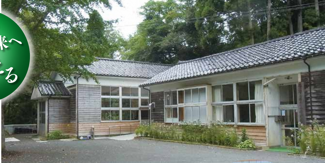
改修後の旧西三川小学校笹川分校外観
