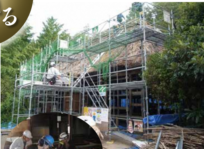
茅材の取り外し
