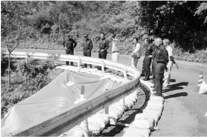
令和2年7月 大雨災害の現地視察
