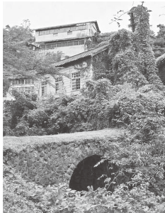
間ノ山上橋(あいのやまかみばし)。コンクリート前のタタキ工法が用いられている(明治後期建設)
