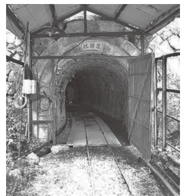
明治32年に開坑した道遊坑
