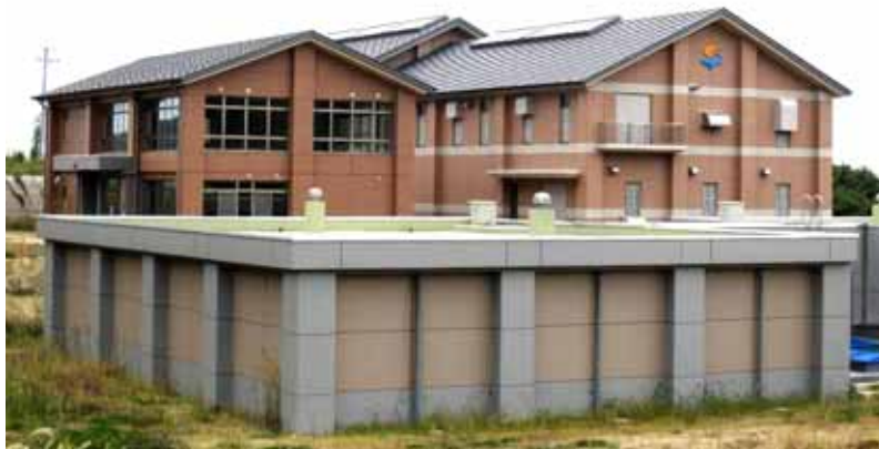
平成 24 年 4 月供用開始予定の相川浄水場
