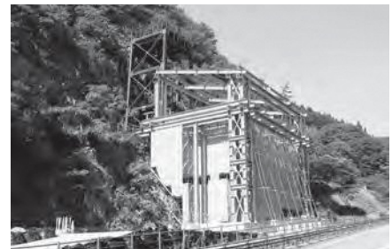
相川地区にある大立竪坑槽
