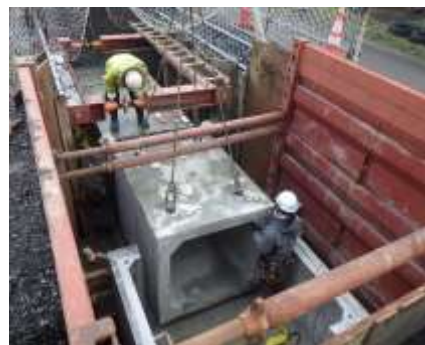
雨水管の布設の様子
