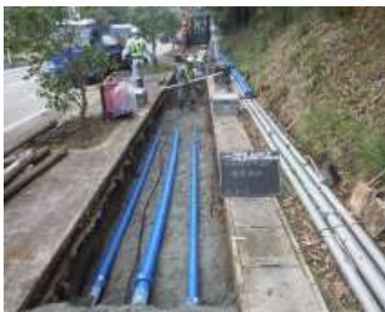
耐震管の布設替の様子
