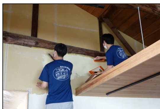
写真 5 塗装作業風景
