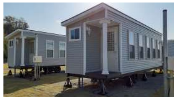
加茂湖湖畔に設置した インキュベーションセンター
