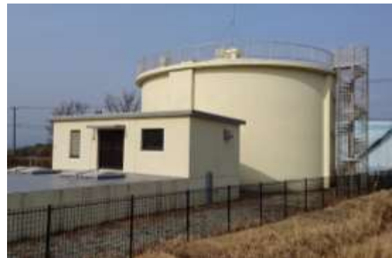
耐震性がある藤巻配水池
