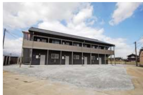
井内住宅（市営住宅）
