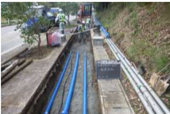
耐震管への布設替
