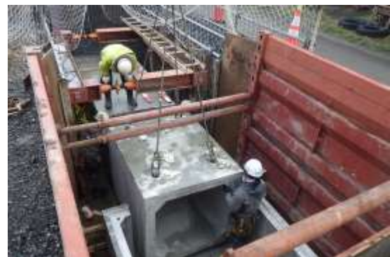
雨水管の布設
