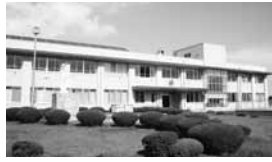
新設日台春日望む津湾を望む 新設された校舎
