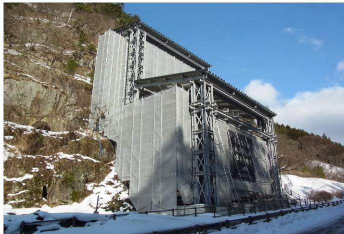
大立堅坑櫓仮設材設置工事後
