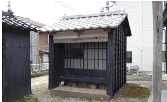
大日堂 屋根修理工事後
