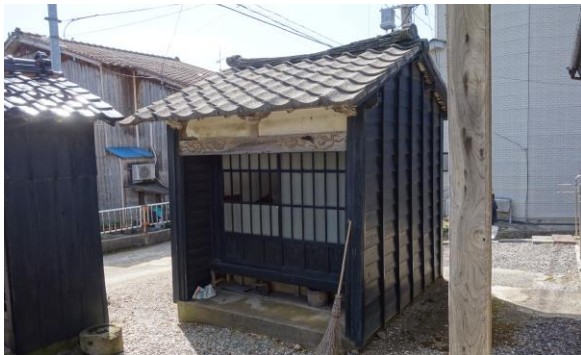
大日堂 屋根修理工事前
