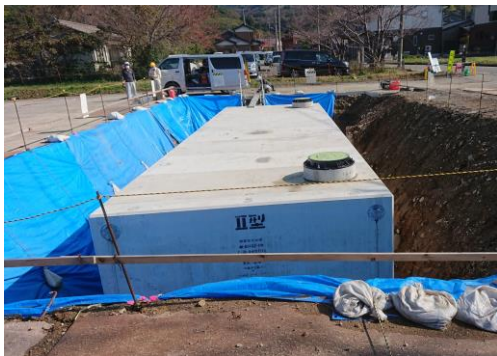
本体(二次製品)設置状況
