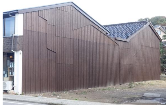
個人商店 壁面修理工事後
