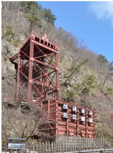
大立堅坑櫓仮設材設置工事前
