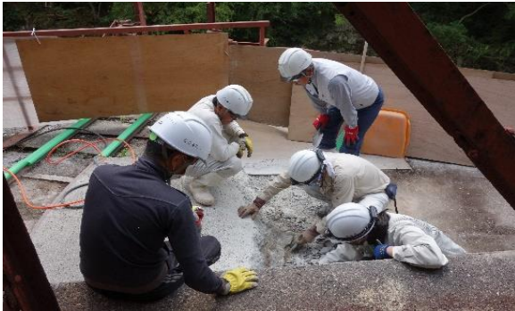
大立竪坑槽保存修理に伴う調査の様子
