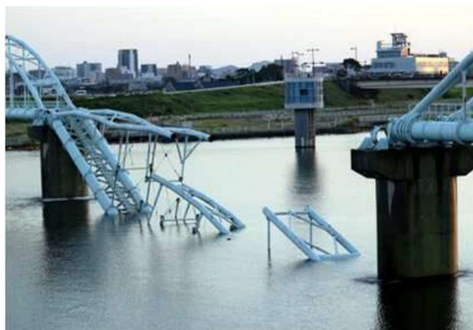
和歌山市・六十谷水管橋の崩落事故
