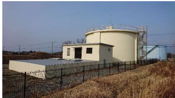
藤巻配水池(両津)
