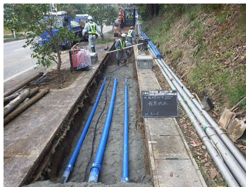
配水管布設工事(小木木野浦地内)
