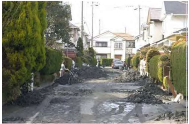
液状化の状況(東日本大震災)
