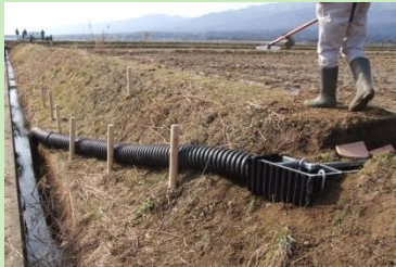
魚道等水路の設置
