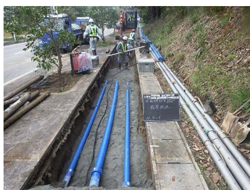
配水管布設工事(小木木野浦地内)
