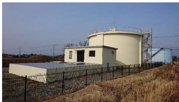
藤巻配水池(両津)
