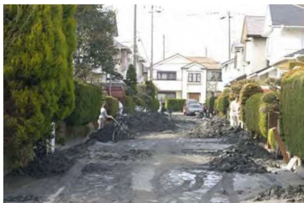
液状化の状況（東日本大震災）
