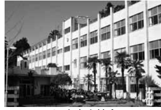
旧小木小学校舎
