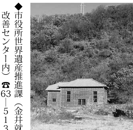
戸地川第二発電所
