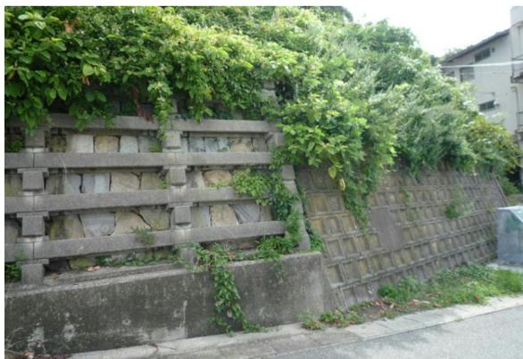
写真 2-246 : コンクリート枠工法による斜面崩落
