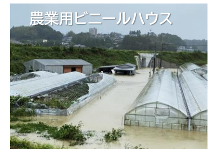
強風・大雨による倒壊・浸水
