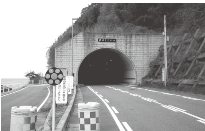
多田集落側から見た多田トンネル入り口
