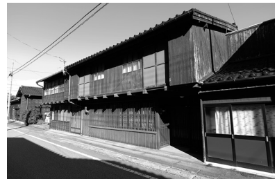
図 5-5-17 二見の町並 南西から
