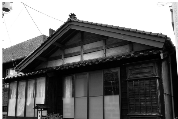
図5-2-9 切妻造妻入の主屋妻壁(No.12)
