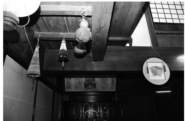
図5-2-2 オモテニカイの張出し下部の架構
