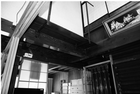
図5-2-1 オイエ吹抜けにみられる横架材の架構
