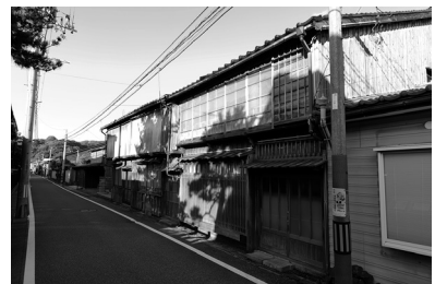
図 5-5-18 相川下町の町並 南東から
