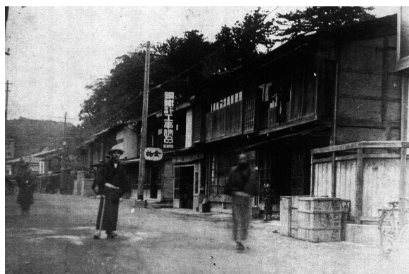
図5-2-6 ガラス障子戸や板戸の建具(中町、明治大火後)
