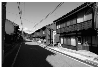
図 5-5-16 二見の町並 南西から
