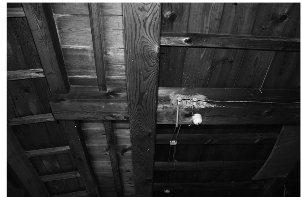
図5-2-5 2階根太(右)と出梁造下部(左)のおさまり
