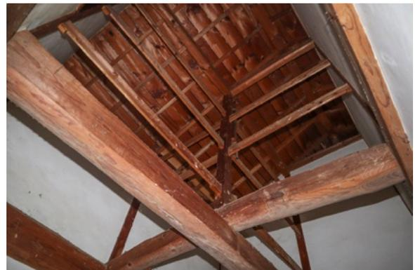
図 4-17-7 オイエ上部の吹抜けの架構 南西から
