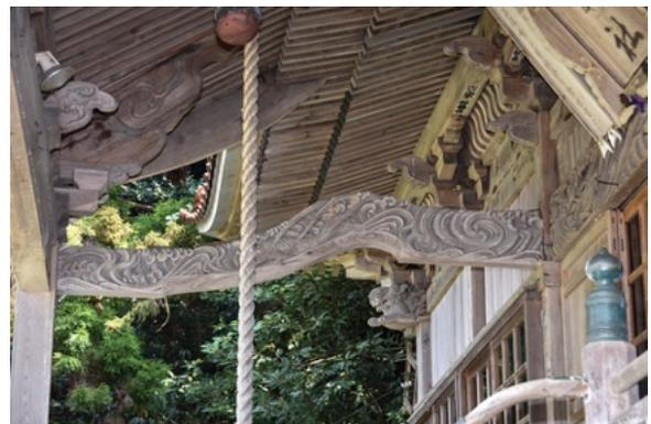
図4-27-6 向拝繋海老虹梁内側の浮き彫り彫刻 西から
