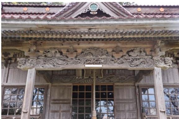
図4-27-5 拝殿向拝の架構と彫刻 北から
