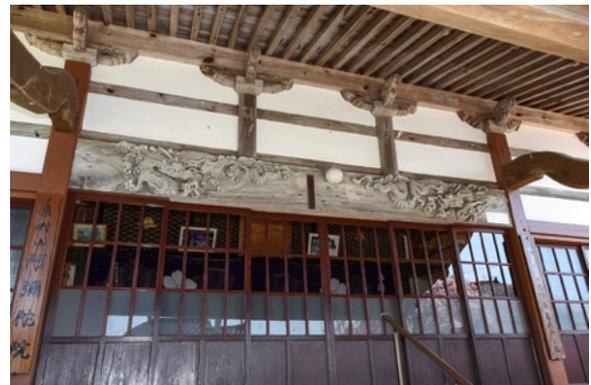
図4-30-3 浮き彫り彫刻を施した差鴨居 南西から
