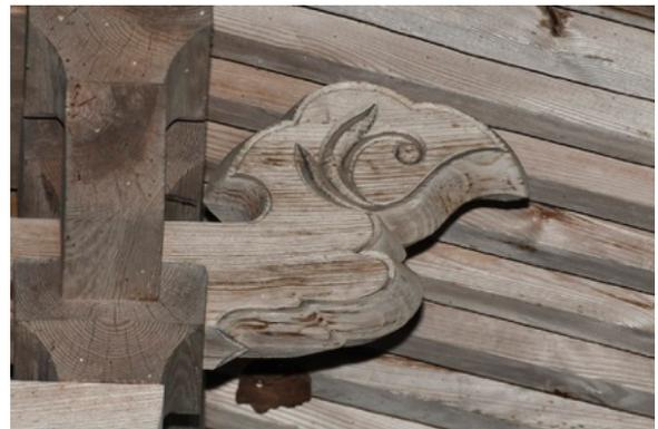
図 4-31-8 鐘楼三手先組物の拳鼻 西から
