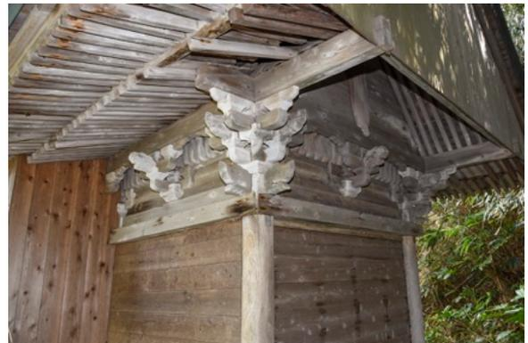
図4-27-14 本殿背側面の架構と組物 南西から
