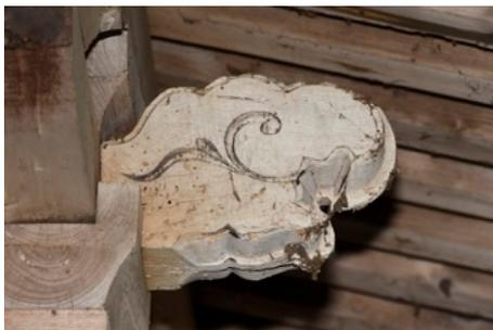
図 4-27-10 鎧に筋状の突起をもつ拳鼻 西から
