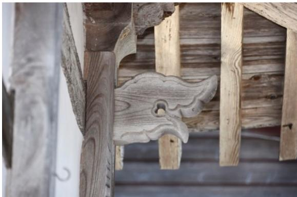
図 4-30-5 頭貫や下に通された飛貫と拳鼻 西から
