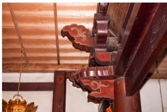
図 4-30-9 来迎柱上の台輪と組物・拳鼻 南東から
