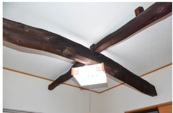
図 4-16-8 当初吹抜けの居室に残された梁組 北東から
