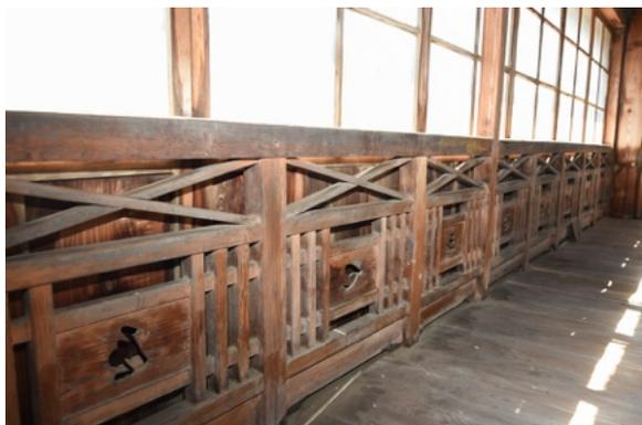
図4-25-10 主屋2階正面縁の高欄 東から
