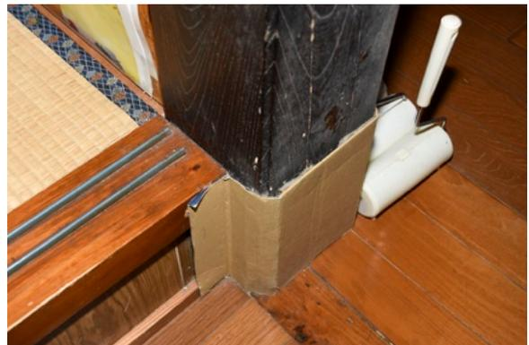
図 4-16-4 当初柱の足元に残る改造痕跡 南西から
