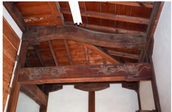
図 4-30-6 入側隅柱上の架構と天井 西から
