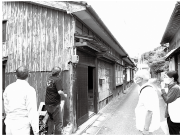
景観保存のための調査の様子
