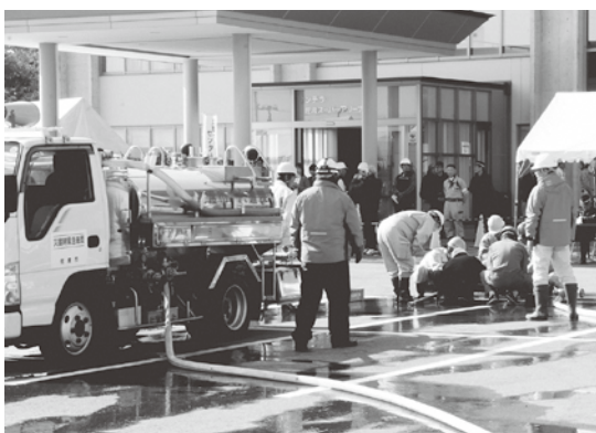
防災訓練での佐渡管工事組合とのライフライン応急復旧訓練の様子
