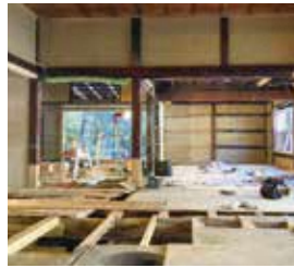
内装工事の様子
