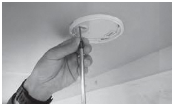
①ネジで取り付けベースを付ける。
