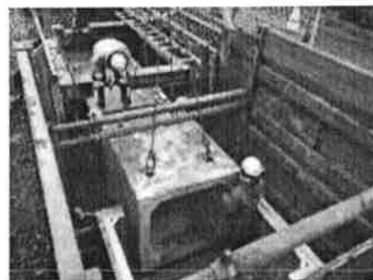
雨水管の布設
