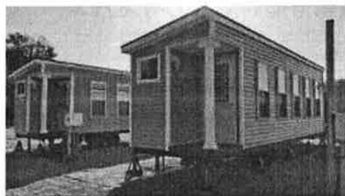
加茂湖湖畔に設置した インキュベーションセンター
