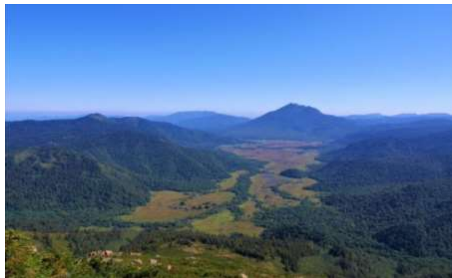
TEPCO尾瀬戸倉の森の全容
