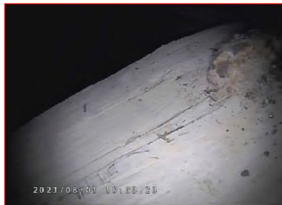
■西側仕口(北より見る) カスガイ留めの先、背割りの埋木に隙間がないことから、設置後に割れは進行していないと考えられる。
