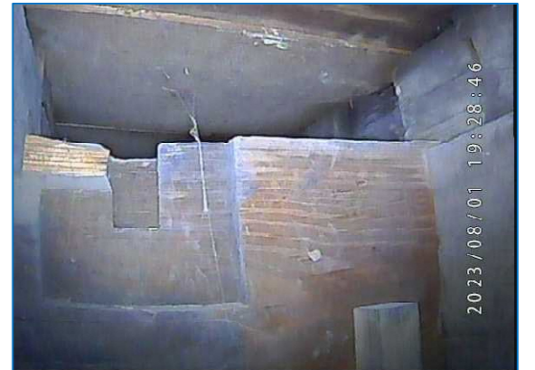
■東側仕口 大引材は転用材のため、前身建物の時期のものと思われる根太掛けと思われる痕跡が確認されたが、部材の強度に大きく影響を与える欠損にはならないと考えられる。
