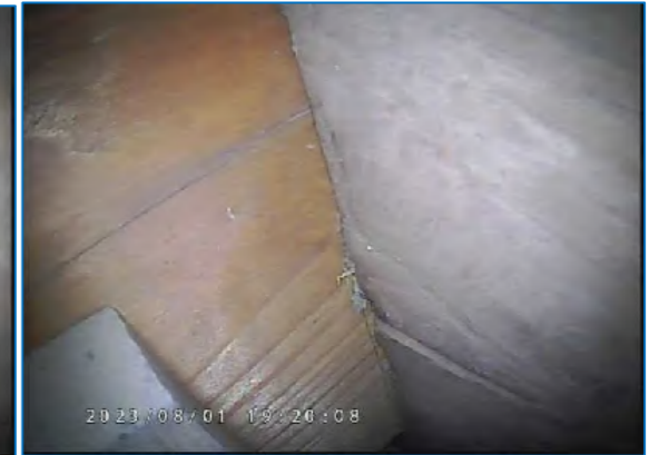
■東側仕口(北より見る) 仕口側面が隙間なく納まっていることから、設置後にズレは生じていないと考えられる。
