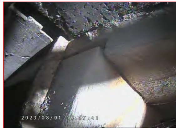
■西側仕口(北より見る) 大梁に対して大引きを大入れとし、上部をカスガイ留めとしていることがわかる。
