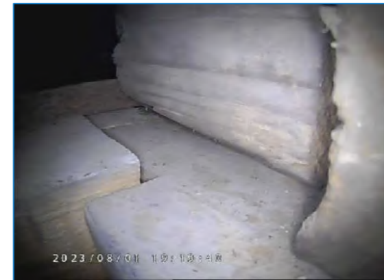
■東側仕口(北より見る) 大梁に対して大引きを大入れとし、上部をカスガイ留めとしていることがわかる。
