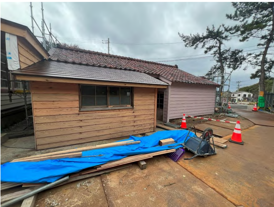
写真 No. 10 旧鉱山本部事務所西棟 外観（北面）下屋
