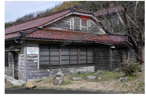
塗装履歴保存のため 塗装しない下見板
