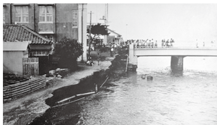
新潟地震でえぐられた加茂湖口の道路
