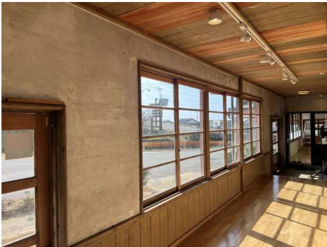
写真 No.13 渡り廊下 (既存部材との区別のため新規材は塗装しない)
