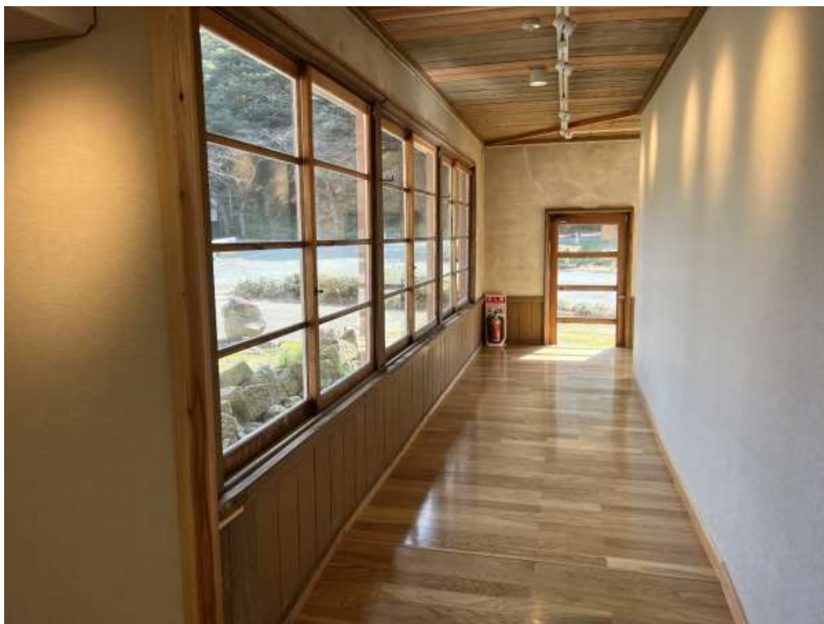
写真 No.11 旧鉱山本部事務所東棟 通路(東側)
