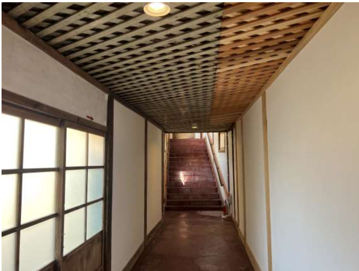
写真 No.13 渡り廊下 (既存部材との区別のため新規材は塗装しない)
