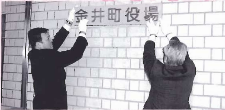
▲金井町 庁舎銘板取り外し
