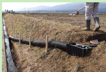
魚道等水路の設置
