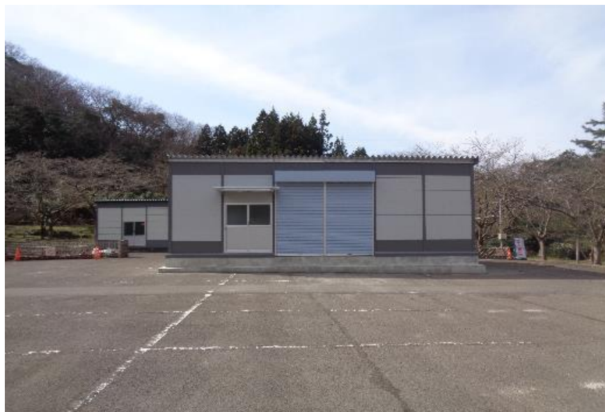
解体材保管小屋の設置
