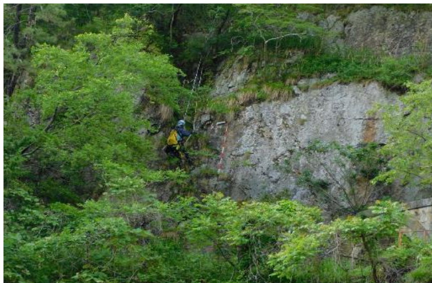
大立地区法面の詳細調査の様子
