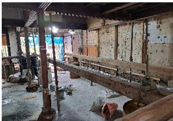
旧深見家住宅内部部材取外し状況
