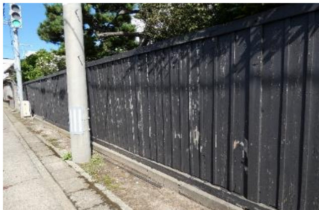
個人宅板塀修理前
