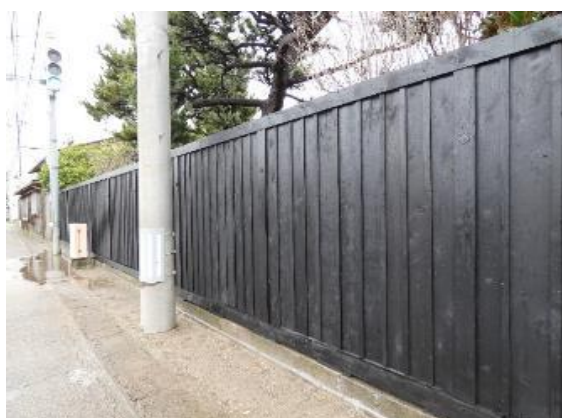
個人住宅板塀修理後
