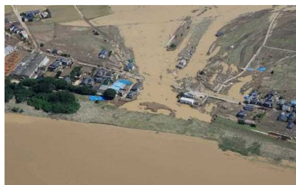
堤防決壊による家屋の流失(鬼怒川)
