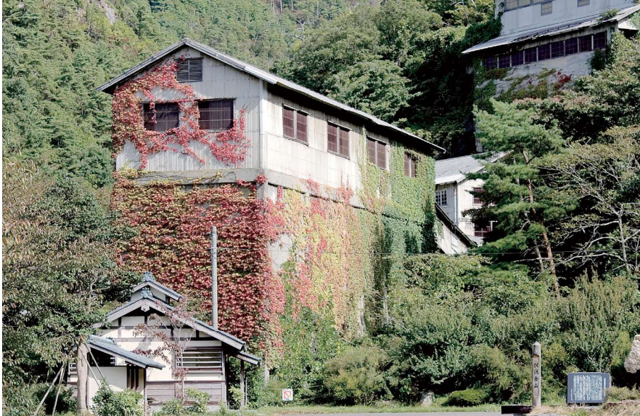
貯鉱舎 1938(昭和13)年に建設され、休山まで使用されました
