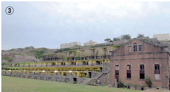
③ きたざわ ふ ゆうせんこう 北沢浮遊選鉱場(左)と火力発電所(右) ここは明治・大正・昭和時代の建物が多く残っている場所です
