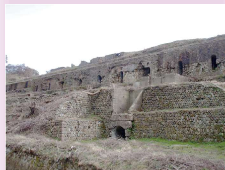
鉄筋コンクリート建造物の保存
