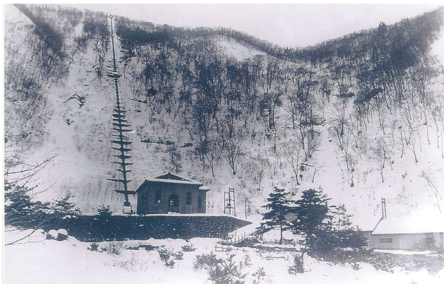
戸地川第一発電所
