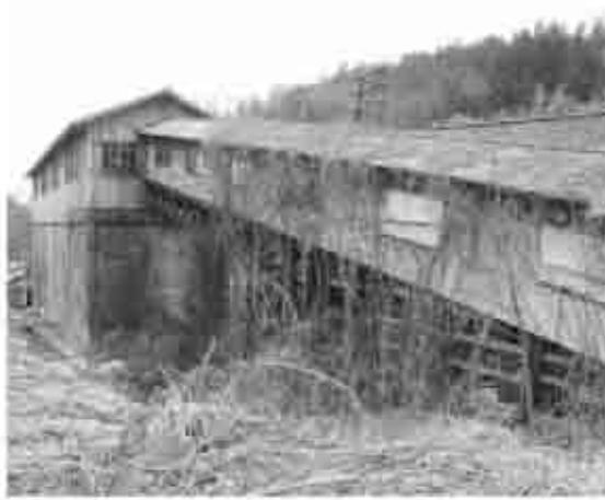
ています。鉄骨造部分は切妻屋根とし、外壁および屋根とも波板スレート張り、内部にはベルトコンベアーが残されていることが確認されています。下部鉄筋コンクリート部は柱梁型を表した外観とし、梁間1スパン、桁行5スパンをとり、最下部は桁行の各スパン間に柱を3本配置し4等分になっています。切妻側から鉱車が2車両並列で進入できる構造で、停車したトロッコの各貨車に上部より鉱石を投入する設備を4か所×5スパンの20か所設けています。ここから濁川沿いに北沢まで軌道が敷設され鉱石を運搬していました。現在、県道
