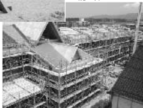
▼ 新穂小学校校舎改築工事 (施工中)
