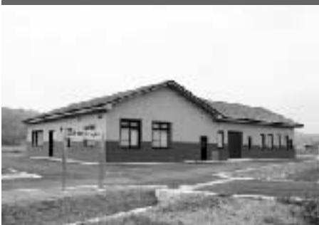
▲羽茂浄化センター管理棟
