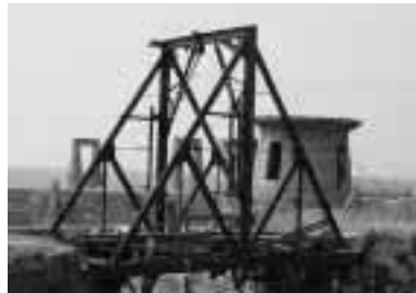
大間港に残るトラス橋
