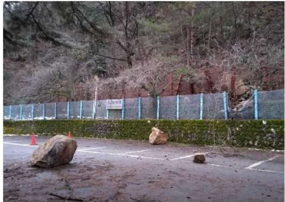
金山第二駐車場の落石（新潟気象台 提供）
