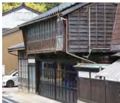
2階の張り出し
