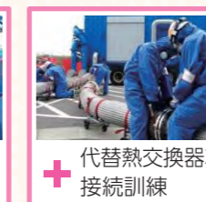
+ 代替熱交換器車接続訓練
