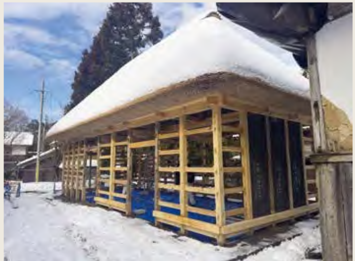
修理が進む牛納屋の様子
