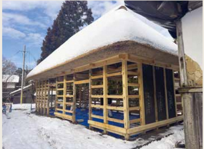
修理が進む牛納屋の様子
