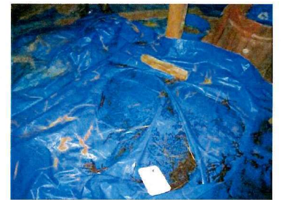
写真17 雨漏り 天井上にブルーシートを敷いて雨漏り対策をしている。棟からの雨漏りは進行中である。雨水が溜まり、部材を蒸けさせて、腐朽の原因となっている。
